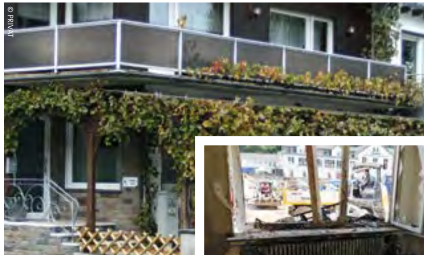
Das unbeschädigte Praxisgebäude (links) vor der Flutkatastrophe und das Ausmaß der Zerstörungen danach. Erste Spenden sind angekommen, werden vorerst aber nur einen Bruchteil der hohen Schadenssumme abdecken.
